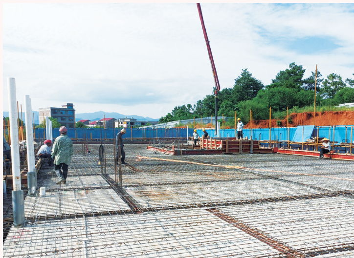
流光岭中心卫生院项目建设中。
