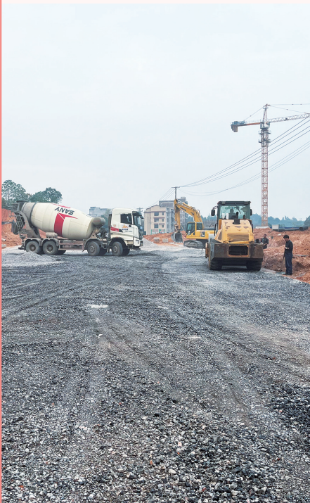
320国道降坡改造工程。
