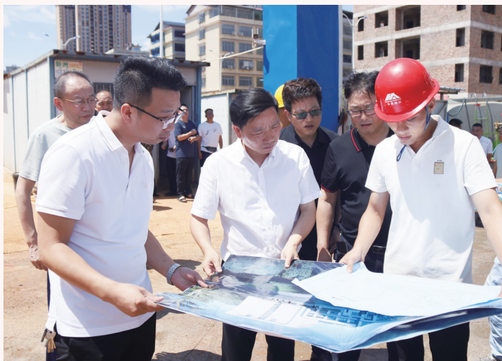
邵东市重点采煤沉陷区乡镇卫生院搬迁及改扩建项目现场。
