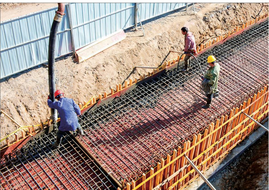
12月16日,施工人员在邵阳县金石镇迎春街白公渡大桥新改建的排污渠道上浇筑混凝土。为完善城市基础设施功能,今年该县加大县城基础设施建设投入,对部分沿江排污渠道进行扩大流量口径增容改造,确保废水污水流入污水处理厂处理。 郑国华 林海燕 摄影报道
