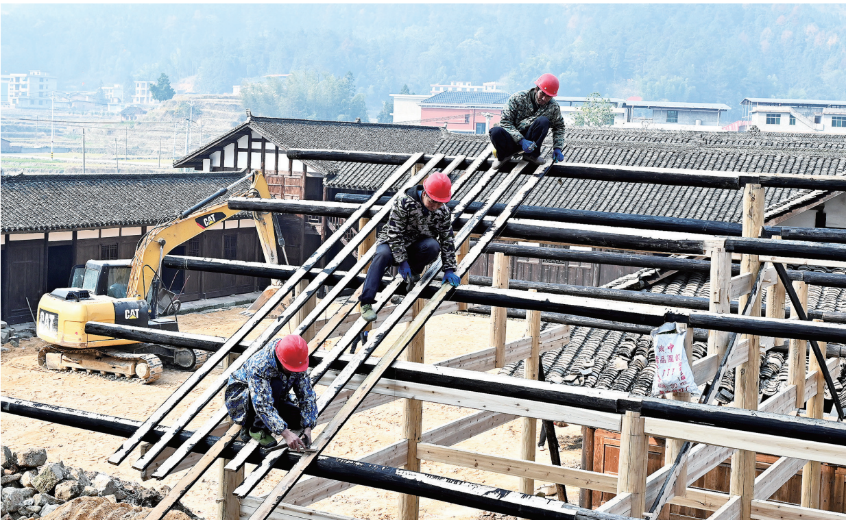
12月4日,施工人员在隆回县罗洪镇邹汉勋故居进行修缮作业。邹汉勋是中国近代舆地学奠基人,其故居是湖南省文物保护单位,因年久失修整体风貌破损严重。目前,该县争取上级资金,对故居进行全面修缮。 贺上升 摄
