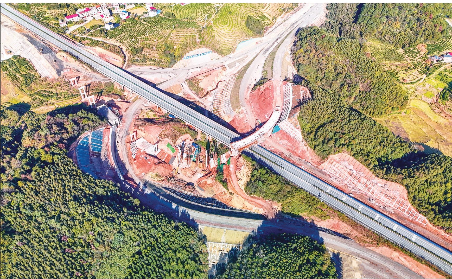
12月1日,航拍新宁县金石镇杨柳田村老人冲,新新高速公路二标段互通枢纽跨路高架桥上,工人们正在施工作业。当前,该互通枢纽路基成型,工程进入跨路高架桥梁施工阶段,2025年底前可实现竣工通车。
