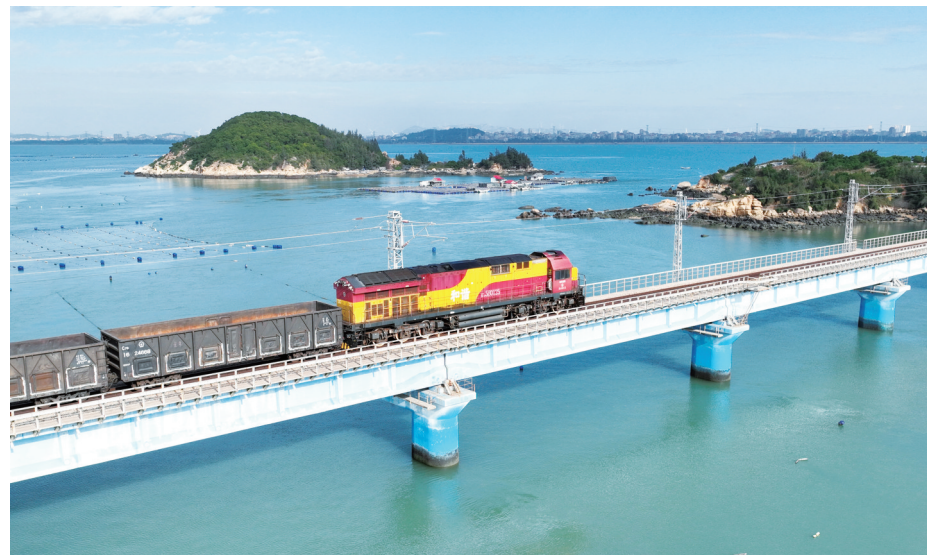
2023年11月29日,装运铁矿石的海铁联运班列经过福建莆田湄洲湾港罗屿作业区附近的一座桥梁(无人机照片)。新华社记者 林善传 摄
