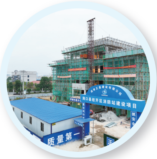
▲建设中的经开区消防站。
