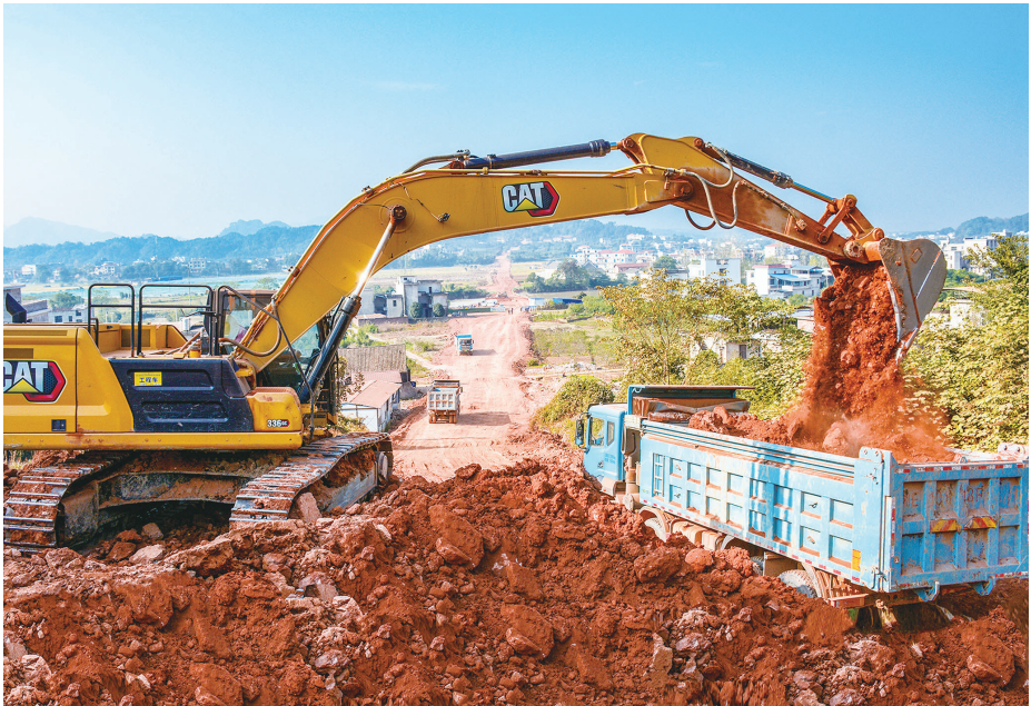
近日，挖掘机、运土车在新宁县金石镇幸福村江黄公路路基上运土施工。今年，该县江黄公路首段开工建设，目前，路基基本成型。
