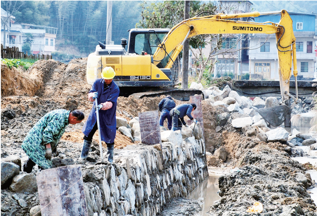
11月12日,施工人员在隆回县金石桥镇五罗村砌河坎。入冬以来,该镇抓住晴好天气,开展水利冬修。
