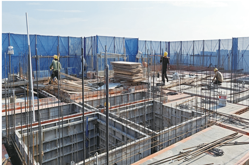
11月12日,双清区盛阳·麒麟荟项目现场,工人们正在1号栋工作面上进行封顶钢筋施工。 朱大建 杨志强 摄影报道
