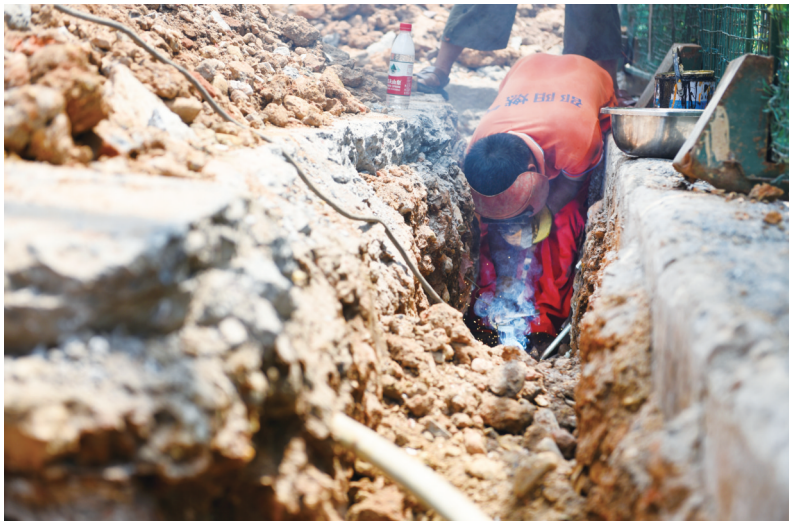
▲抢修人员对燃气管道进行抢修。 申兴刚 摄
