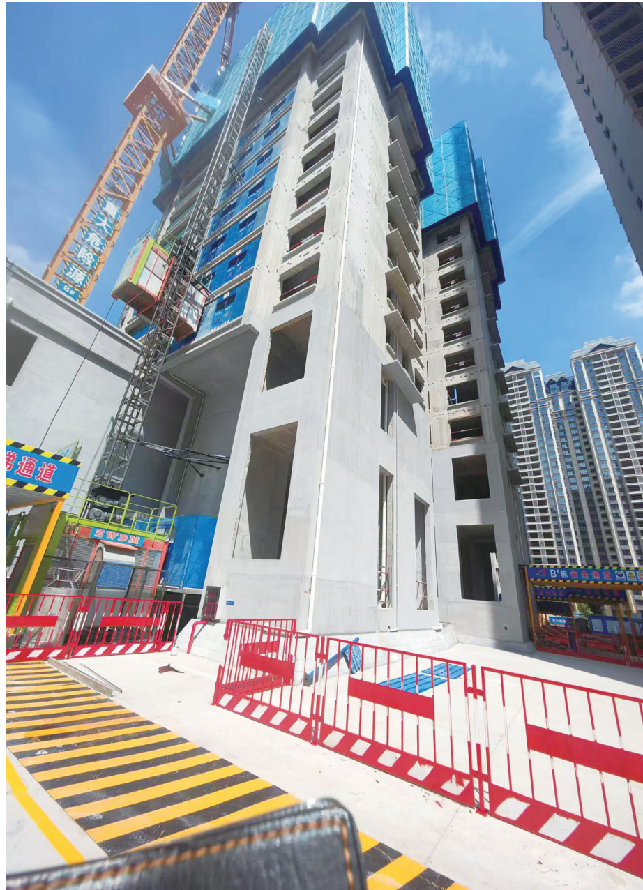
南方紫鑫项目A栋建筑主体结构已封顶,正进行外立面施工。
