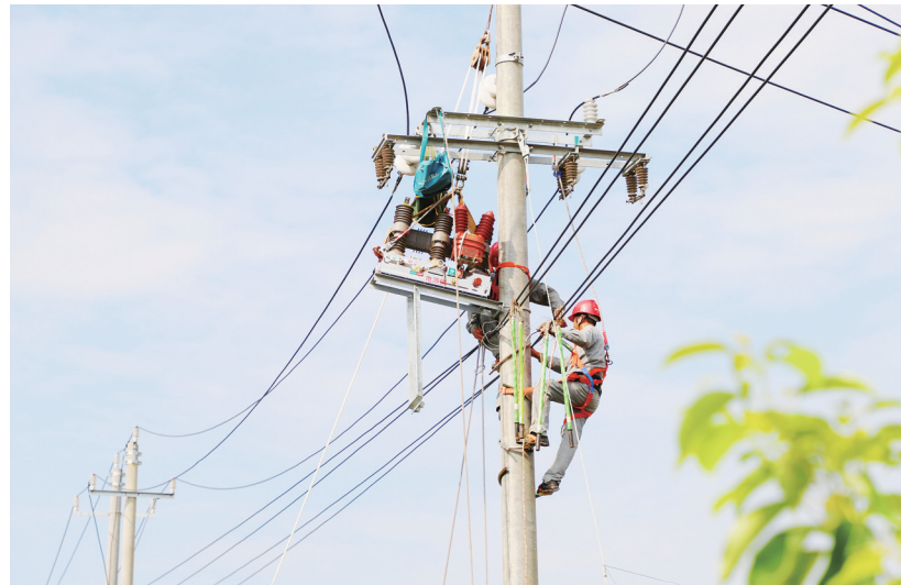
国网新邵县供电公司集中精干力量在多个作业面开展检修消缺作业，从源头上降低线路故障率，全力保障广大群众用电安全可靠。图为8月28日，该公司组织对10千伏言向线开展防雷治理改造工程及集中检修施工。
