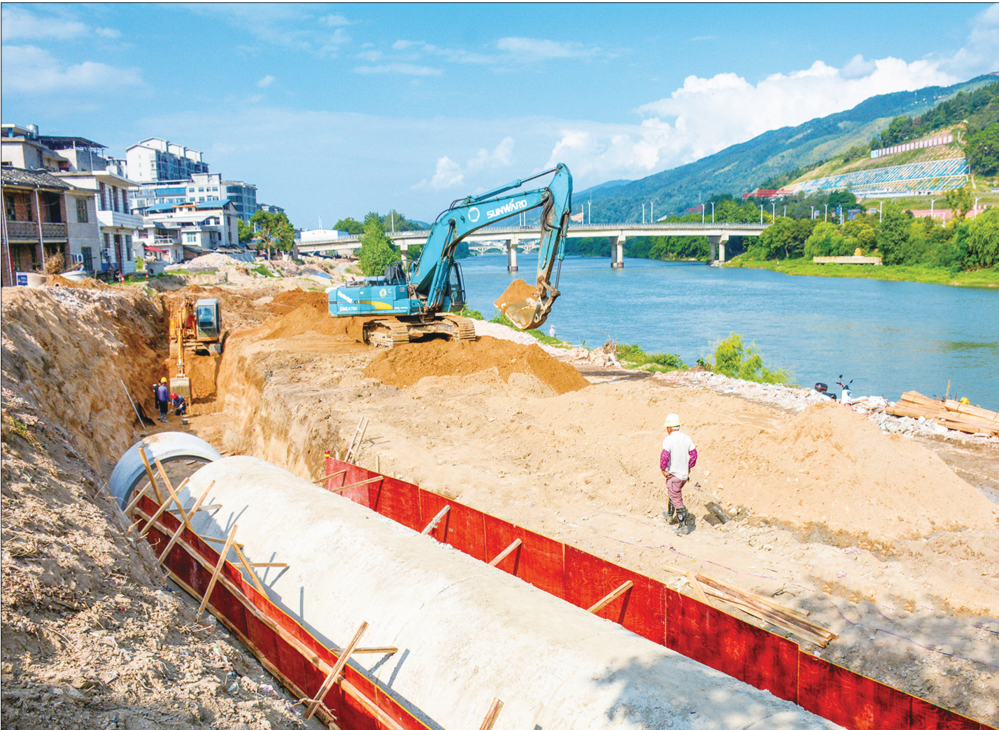
8月29日，在新宁县城夫夷江湘水大桥上游江岸边，工人正在安装排水管道。今年，该县投资9000多万元，在夫夷江沿岸规划建设一条宽8米、长5.1公里的沿河路，打造集绿化亮化休闲于一体的沿江风光带。 郑国华 摄
