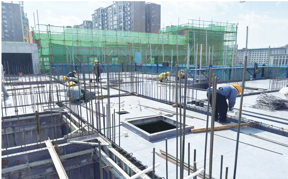
7月23日,汇福·白洲湾项目施工现场,建筑工人在钢筋“丛林”里来回穿梭,争分夺秒地赶进度、抢工期。 朱大建 龙建云 摄影报道
