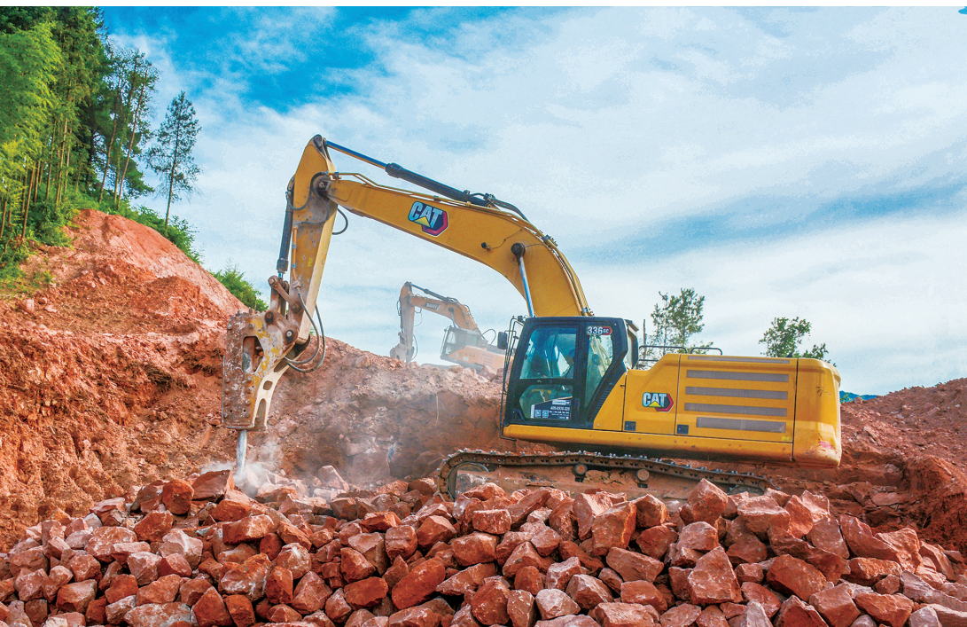
7月14日,新宁县金石镇飞仙桥村山坡上,2台炮机正在施工作业。今年,该县动工改造江黄公路,途经金石、水庙、麻林、黄金4个乡镇,全长54.18公里,路面宽8.5米,项目总投资90637万元。 郑国华 摄
