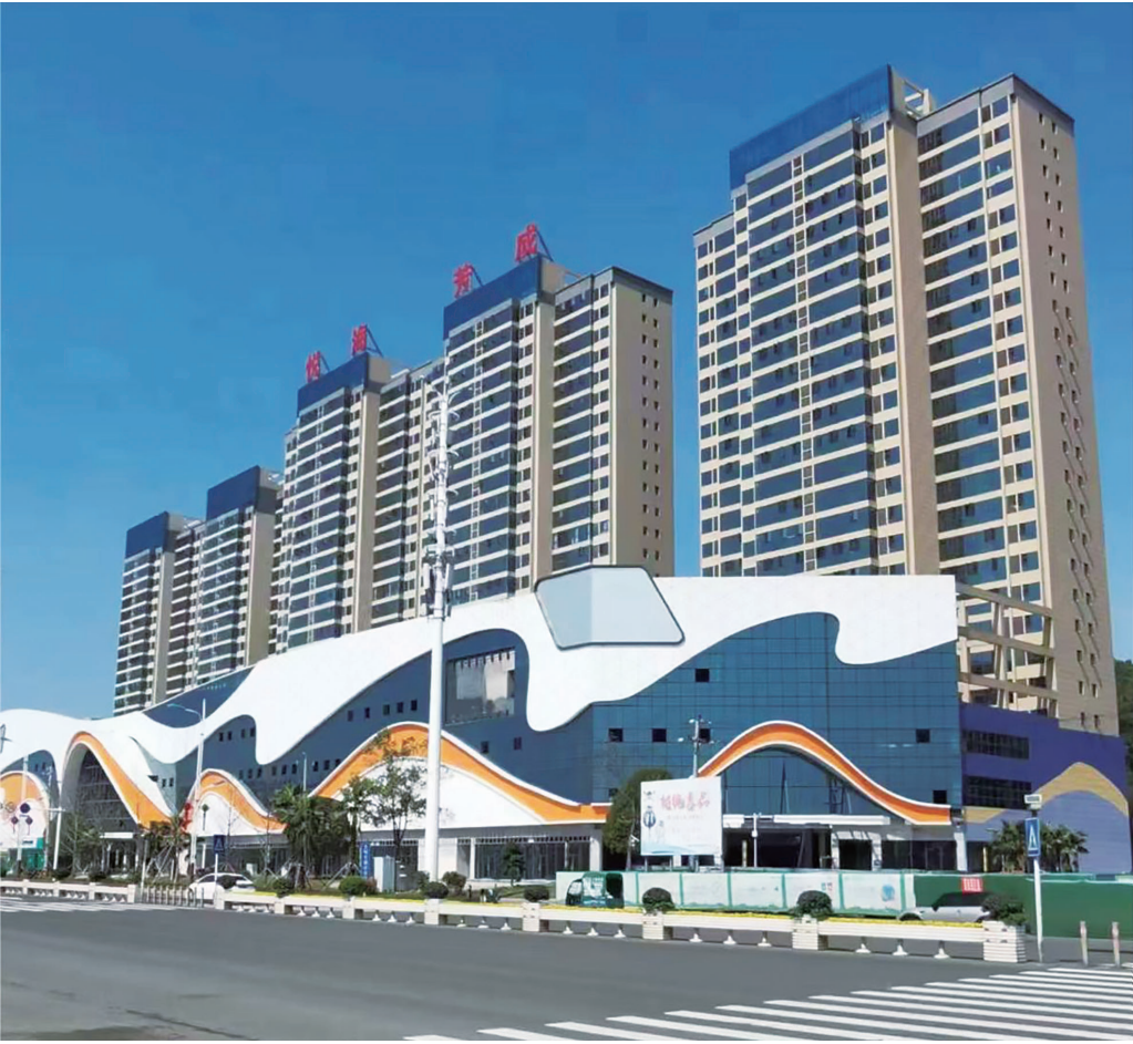
6月19日,市双清区悦海芳成项目外立面施工已完成,商业部分正在招商。
