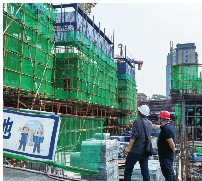
5月21日，市双清区盛阳·麒麟荟项目建设工程施工现场热潮涌动，一片热火朝天的景象。
