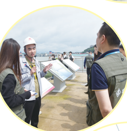
▲在犬木塘水库枢纽工程建设现场,学员们实地了解工程建设情况。
