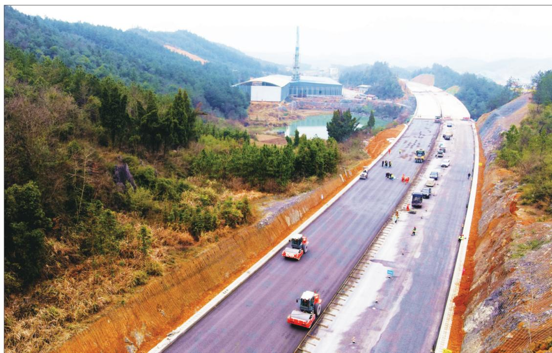
3月13日,永州至新宁清江桥高速公路(简称永新高速)第四合同段水泥稳定碎石下基层试验路摊铺顺利完成,标志着该合同段路面工程进度迎来新突破。邵阳日报记者 刘波 通讯员 杨微 黄熙程 摄影报道
