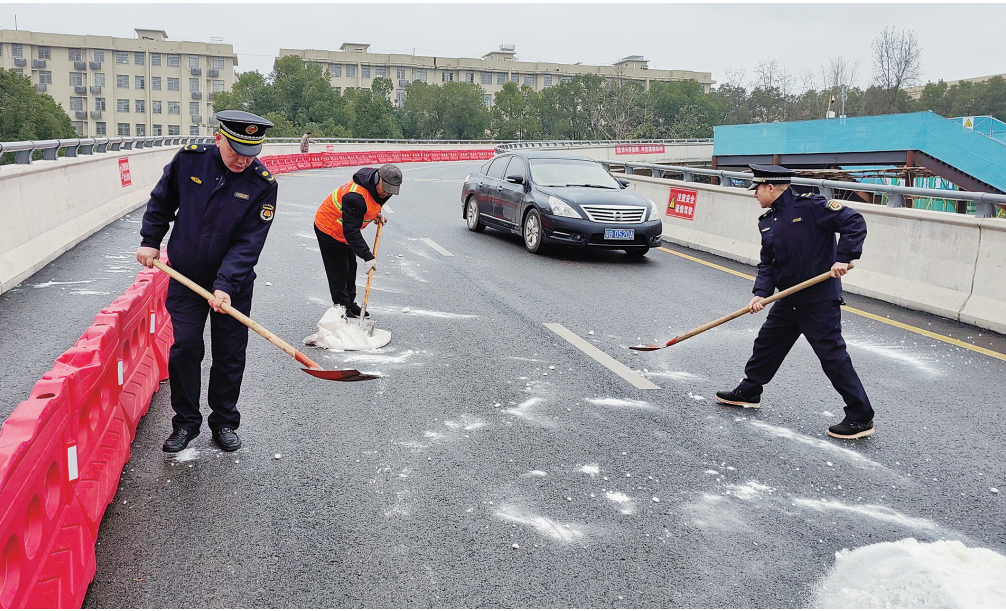
2月23日,为应对低温雨雪冰冻天气,市城市管理和综合执法局组织干部职工及环卫工人对邵阳火车站出入口匝道撒盐、铺设防滑垫,保障市民安全出行。 邵阳日报记者 申兴刚 通讯员 姚峰 摄影报道
