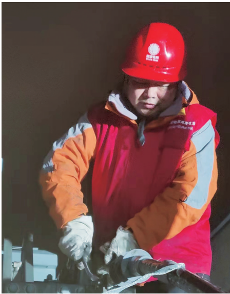
变电检修工作人员在开展线路融冰工作。
