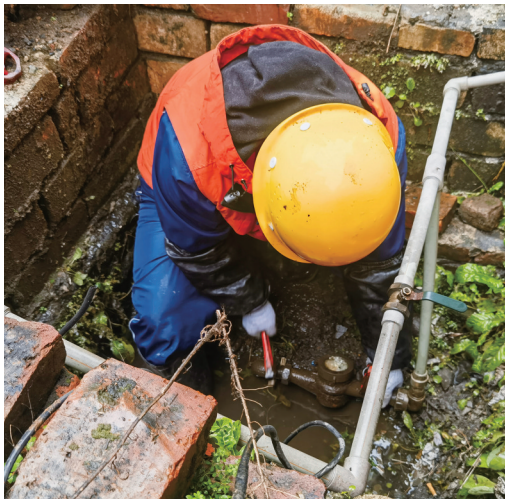
“水宝宝”服务队队员陈斌在井内拆除破损水表。
