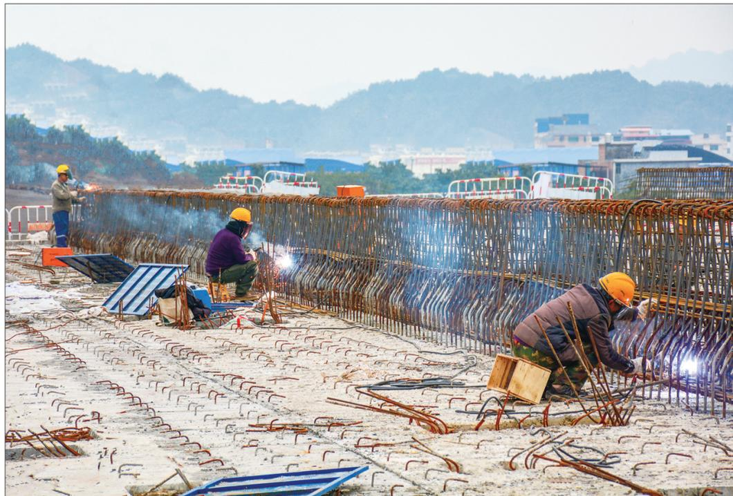
1月9日,新宁县金石镇金夷村,施工人员正在新新高速公路二标段1号高架桥桥面上焊接隔离护栏。
