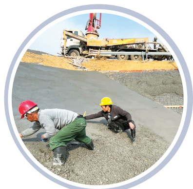
◀邵阳县人大常委会促成的民生项目——九公桥镇元塘水库除险加固施工现场。刘豪健 摄
