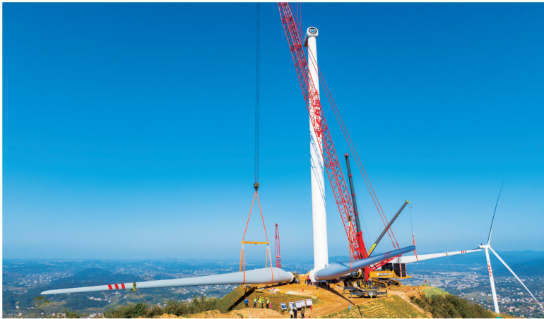
邵东皇帝岭风电场施工现场。 刘海 摄
