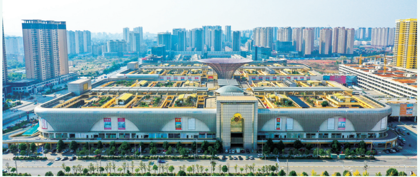
邵东兴工旺商重要载体、市场转型升级龙头项目之一——邵东国际商贸城。
