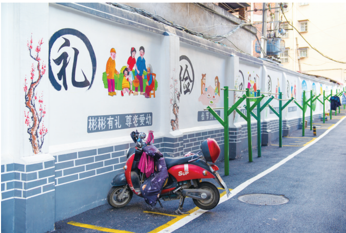
改造后的双清区鼓楼亭社区一角。
