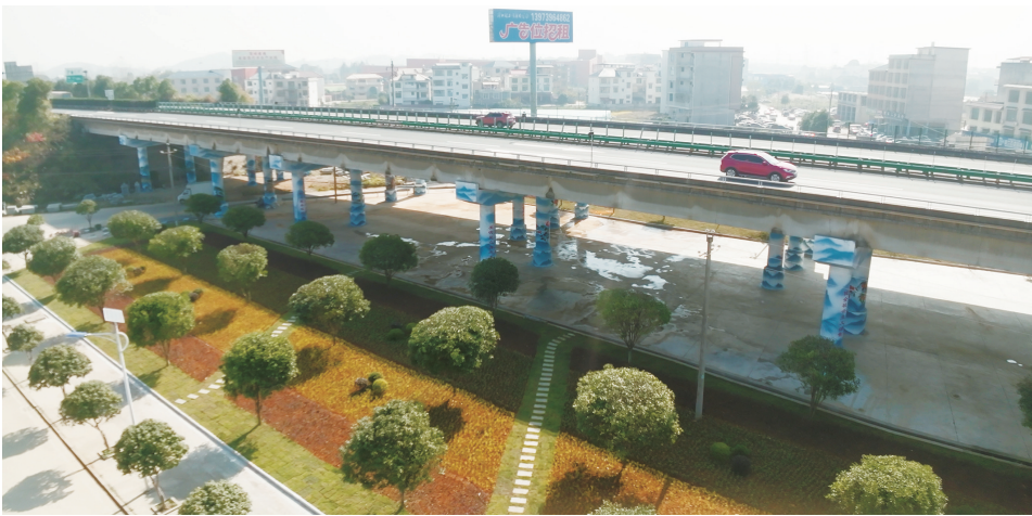
整治后，沪昆高速洞口互通高架桥下“畅舒美”。
