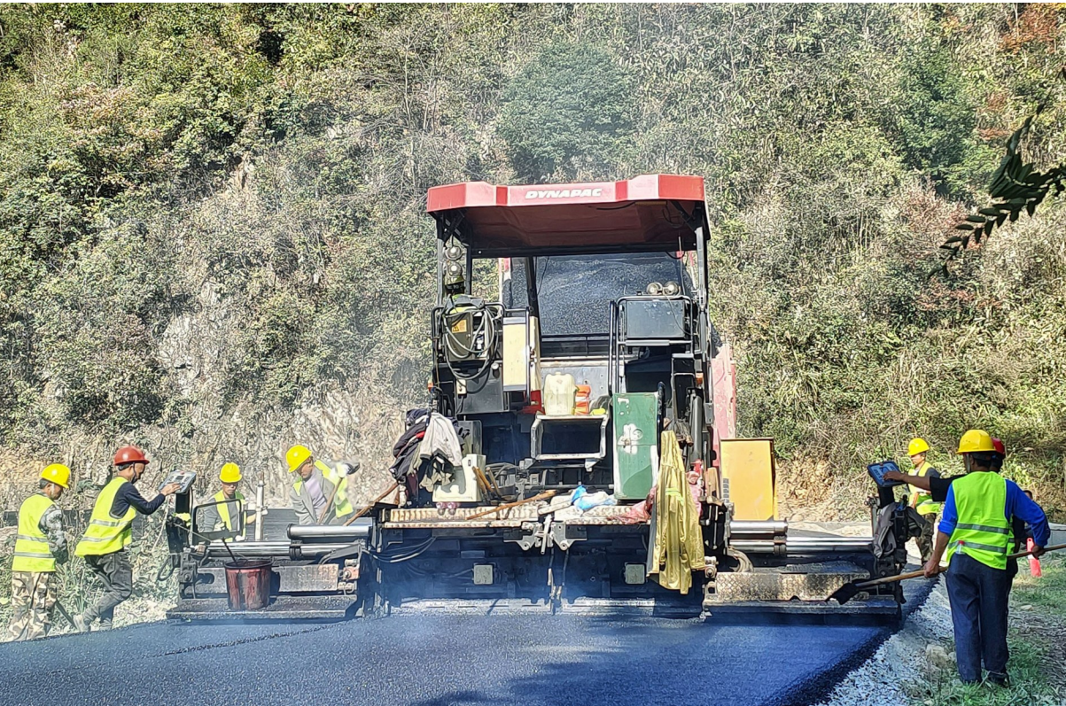
11月27日，城步苗族自治县儒林镇矮岭子至冒水井村路段改造提升工程施工人员在进行铺设沥青作业。近年来，该县每年安排近5000万元财政资金，加强对农村重要公路的改造升级，全面改善农村出行条件，助力乡村振兴。严钦龙 刘海波 摄影报道
