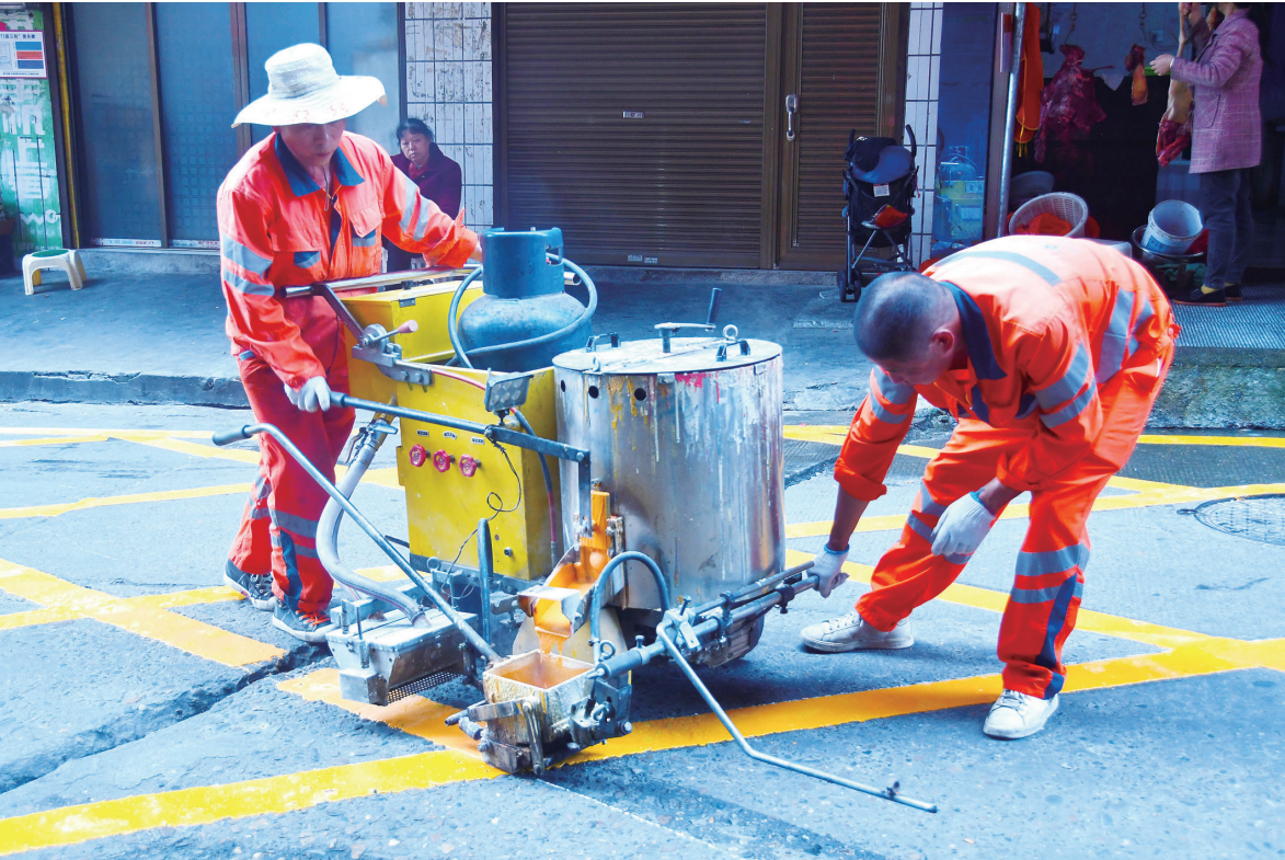
10月31日，工作人员在新邵县酿溪镇仁山路进行热熔标线施工，确保消防通道畅通。今年来，该县对11个老旧小区进行改造，包括屋顶防漏、增设休闲设施、施划消防标线等，惠及广大社区群众。 邵阳日报通讯员 何雯 摄
