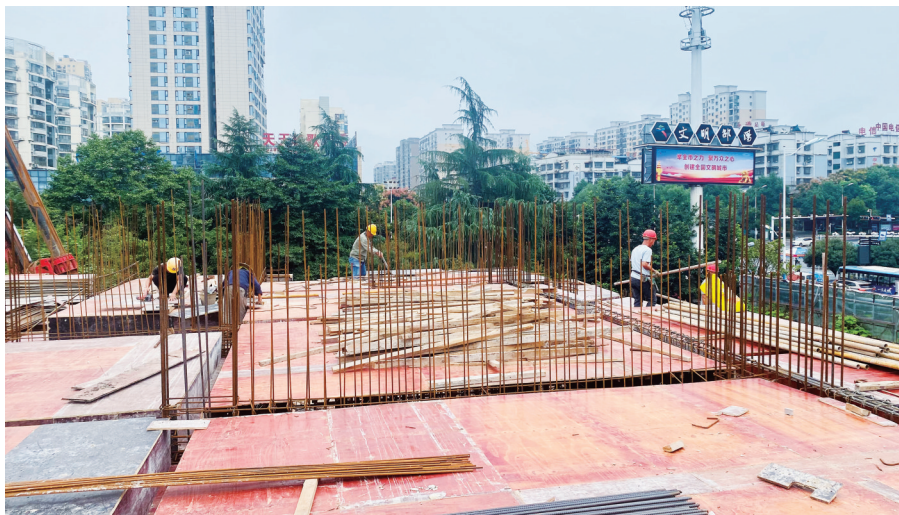
9月26日,中驰·国际项目施工现场,建筑工人正在进行屋面施工。 朱大建 唐华平 摄影报道
