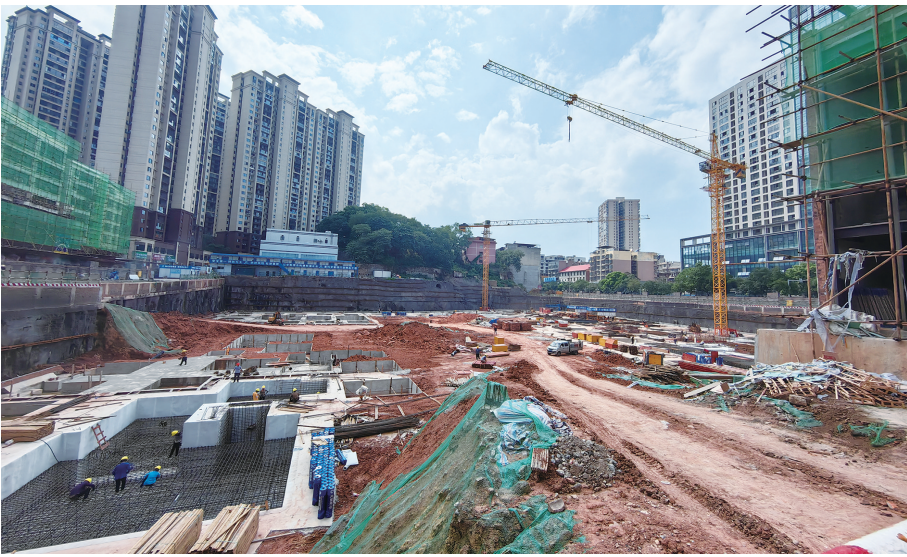
9月19日,大汉六岭公园恢复性建设及周边棚户区改造项目建设工程三期施工现场,项目建设正有序推进,现场一片热火朝天景象。
