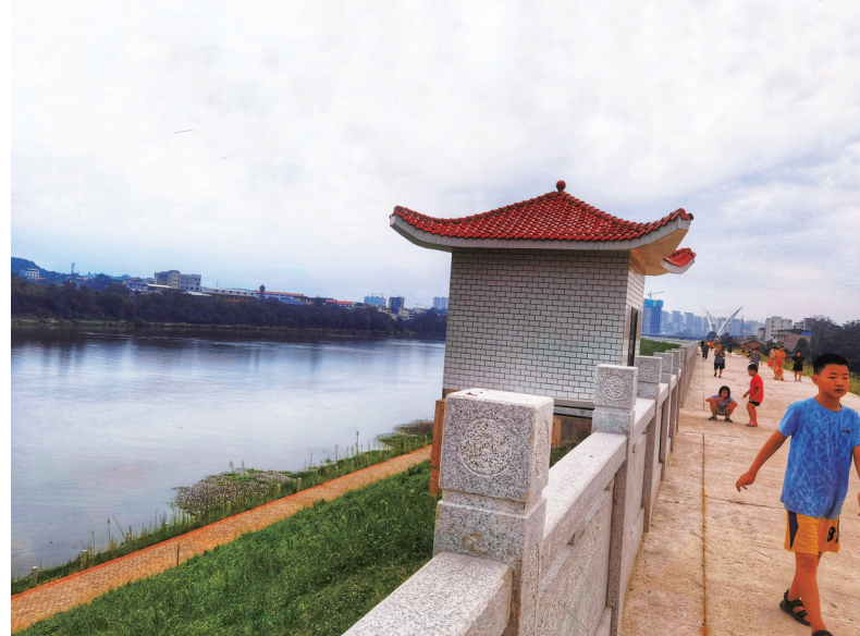
资江南岸雪峰大桥至资江二桥段防洪堤路面最近硬化完工,吸引众多市民每天早晚前往散步、休闲。图为8月31日傍晚,市民在防洪堤上散步。邵阳日报记者 羊长发 摄
