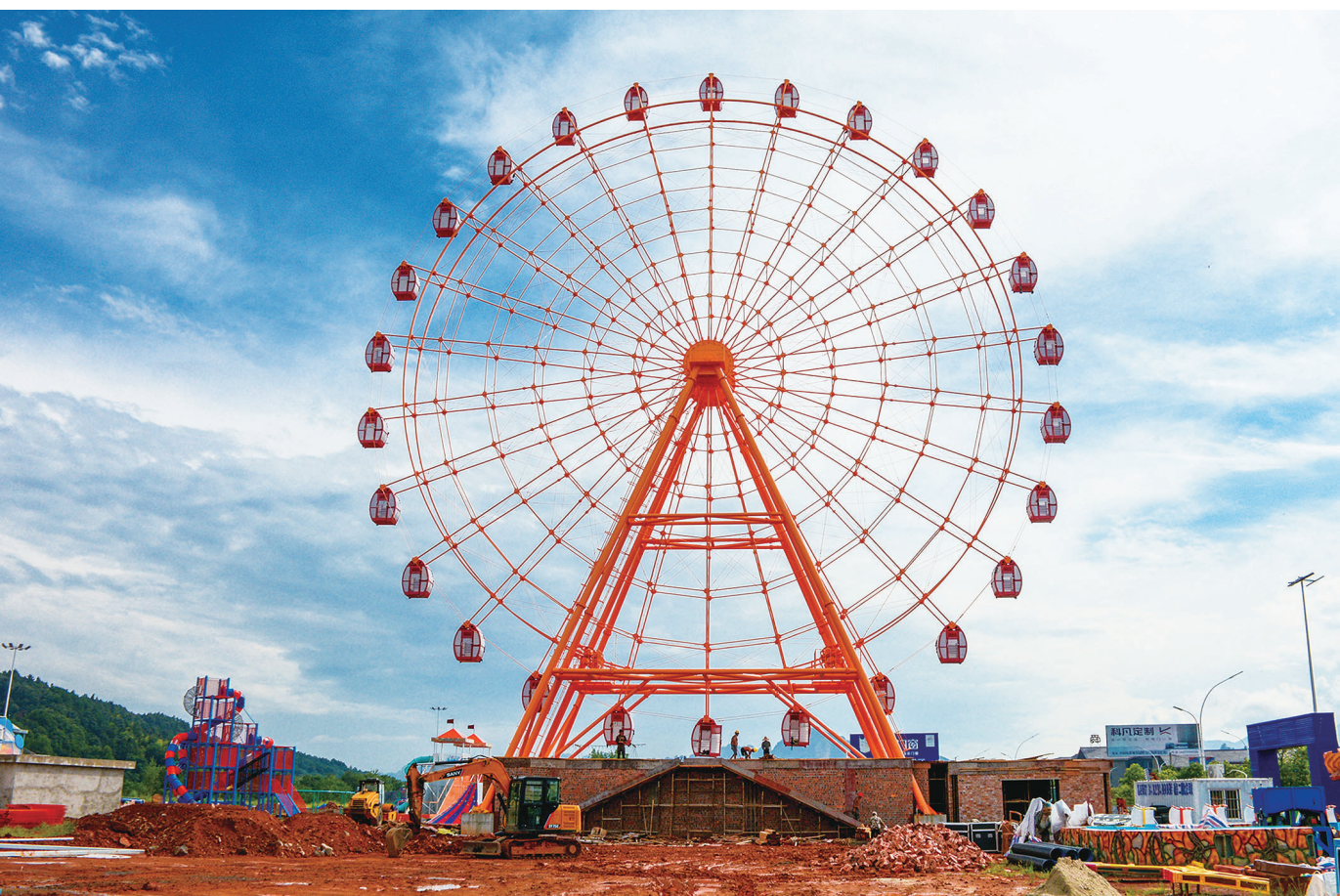
8月22日，在新宁县下马石片区锦绣公园内，施工人员在摩天旋转轮下基座施工。今年，该县在通往崀山北大门的锦绣公园内新建大型娱乐设施，预计该项目将在今年国庆节开始投入使用。
