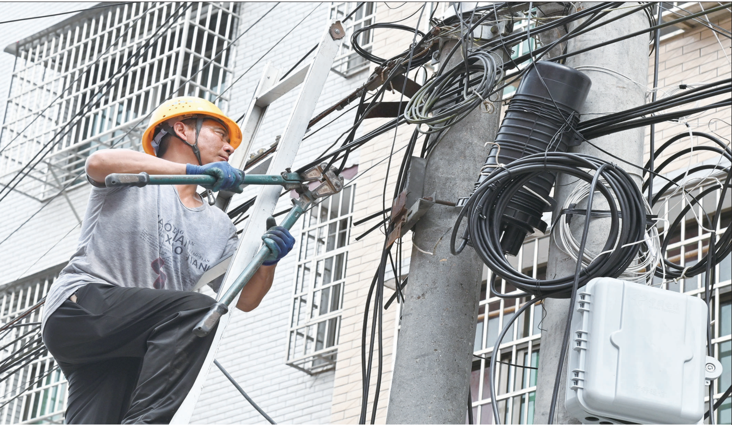
8月8日，隆回县金石桥镇施工队施工人员在黄金井村拆卸“蜘蛛网”线路。近期，该镇在黄金井村实施“弱电入地”提升改造项目，对悬置在主次干道上空的供电、通信、有线电视等线路进行清理，从传统架空改为深埋入地下管道内，以净化生产生活空间、消除安全隐患，积极营造整洁美观、平安有序的社会环境。
