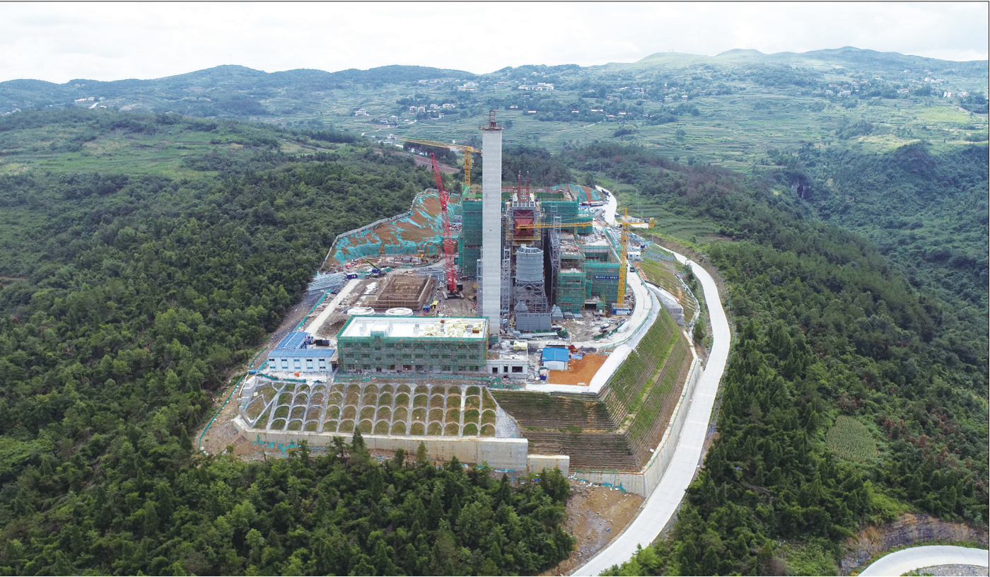
7月20日,位于武冈市稠树塘镇甘田村的邵阳市中部生活垃圾焚烧发电项目正在如火如荼建设中。该项目2022年6月开工,建设总投资3.1915亿元,建成后预计年处理生活垃圾量可达18.25万吨,年发电量可达6860万千瓦时。目前,项目已累计完成投资2.5亿元,已完成总工程量的75%。 邵阳日报记者 贺旭艳 通讯员 王茜霞 沈君华 摄影报道
