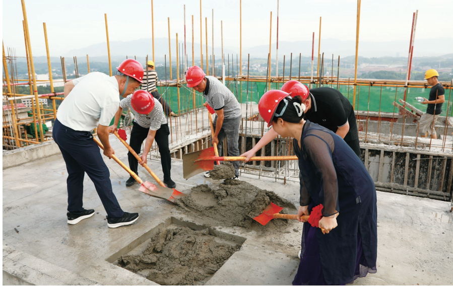
7月16日,华馨佳苑项目1#、2#、3#栋成功封顶。该项目东邻主干道北塔路,南邻云山路,占地约38663平方米,由3栋高层住宅和10栋叠墅组成,绿化面积35%。
