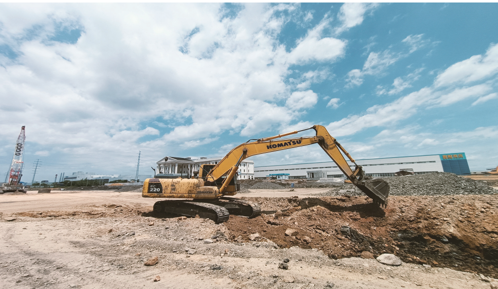
湖口井路项目建设工地,挖机正在进行污水雨水管网开挖作业。
