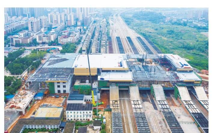
正在建设的邵阳南站综合客运枢纽项目。唐明业 摄
