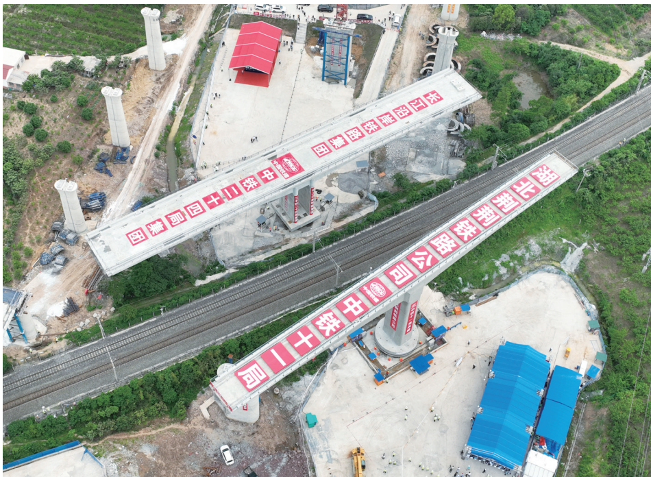
图为荆荆高铁荆门特大桥与沪渝蓉高铁太白集特大桥转体前(5月18日摄,无人机照片)。
