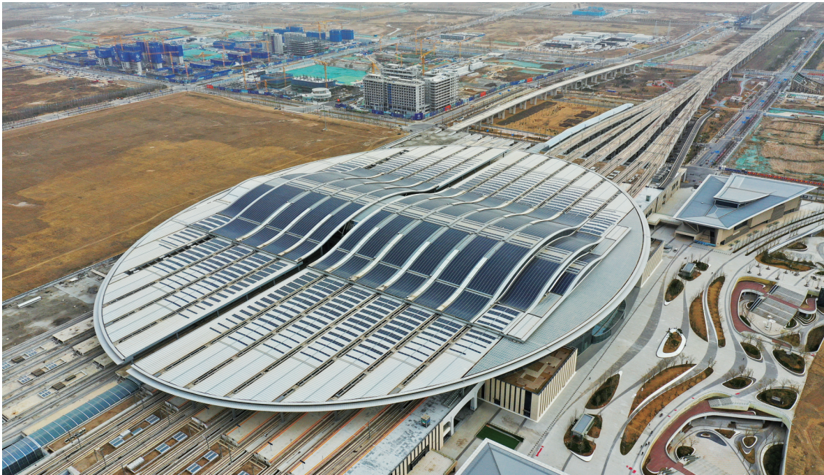
图为京雄城际铁路雄安站(3月23日摄，无人机照片)。新华社记者 牟宇 摄
