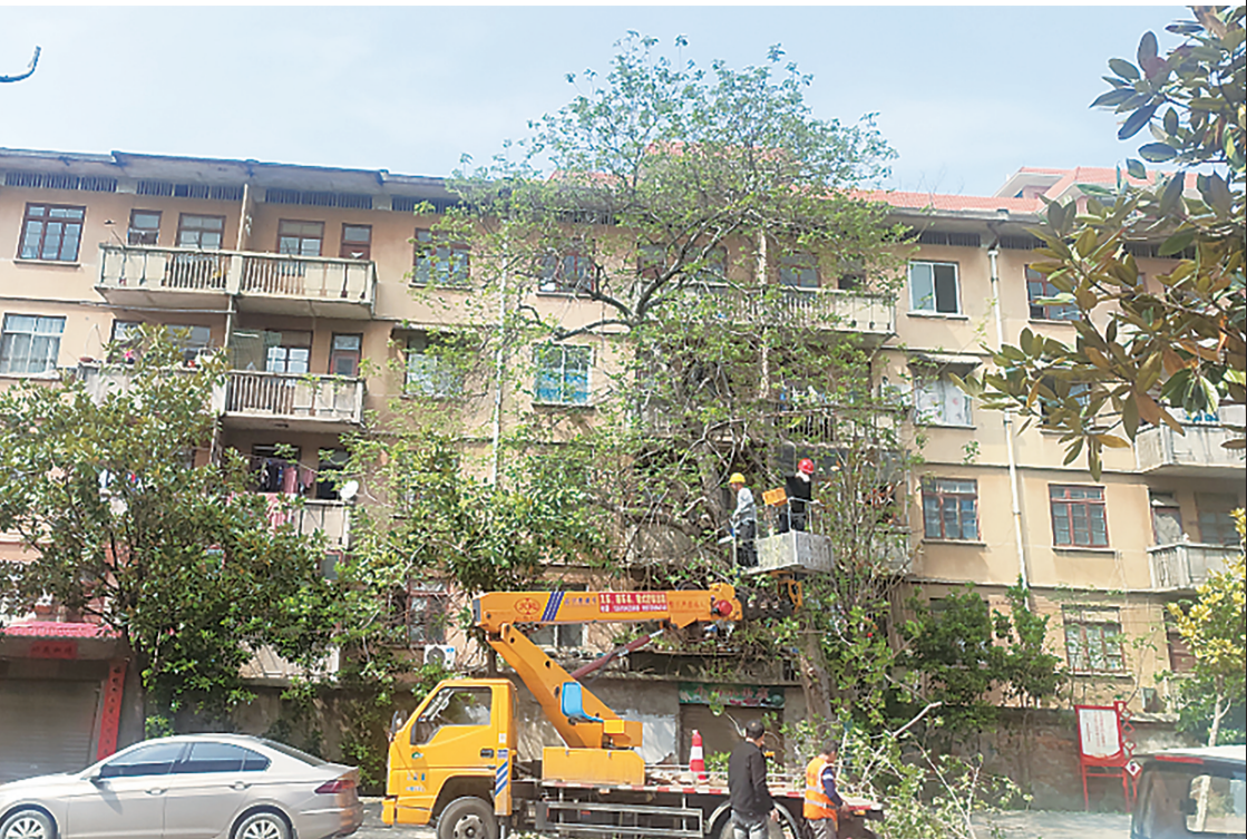
4月7日,施工人员对仙人井社区的一棵影响居民生活的大树进行修剪,消除安全隐患。
