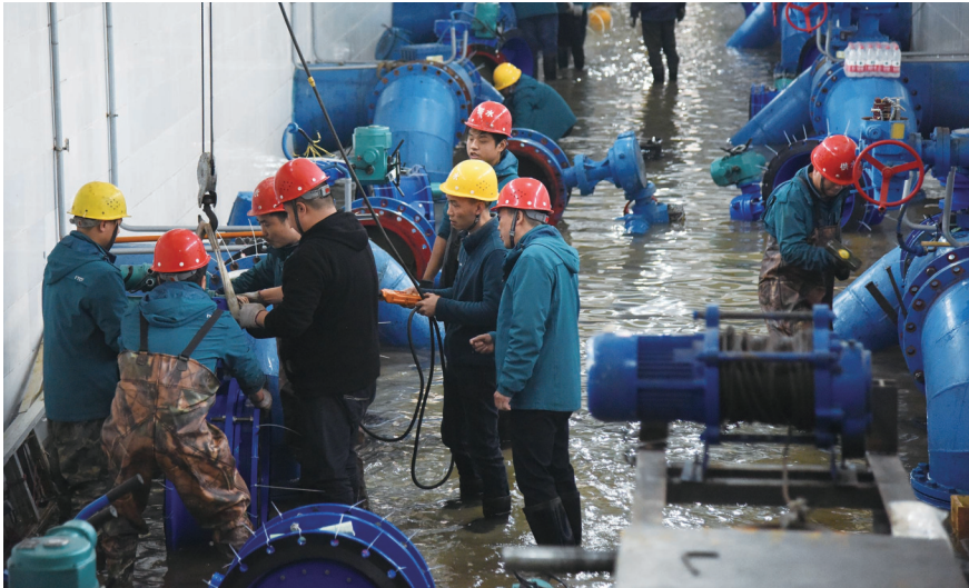
▲技术人员正在更换滤池阀门。
