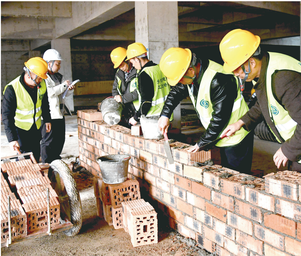
3月24日，新邵县乡村建设工匠培训“送教下乡”活动进入实操训练和考试环节。对考试合格者，该县住建局将统一颁发湖南省乡村建设工匠培训合格证。图为学员在进行砌筑墙体实操考试。邵阳日报通讯员 何雯 唐文峰 摄影报道
