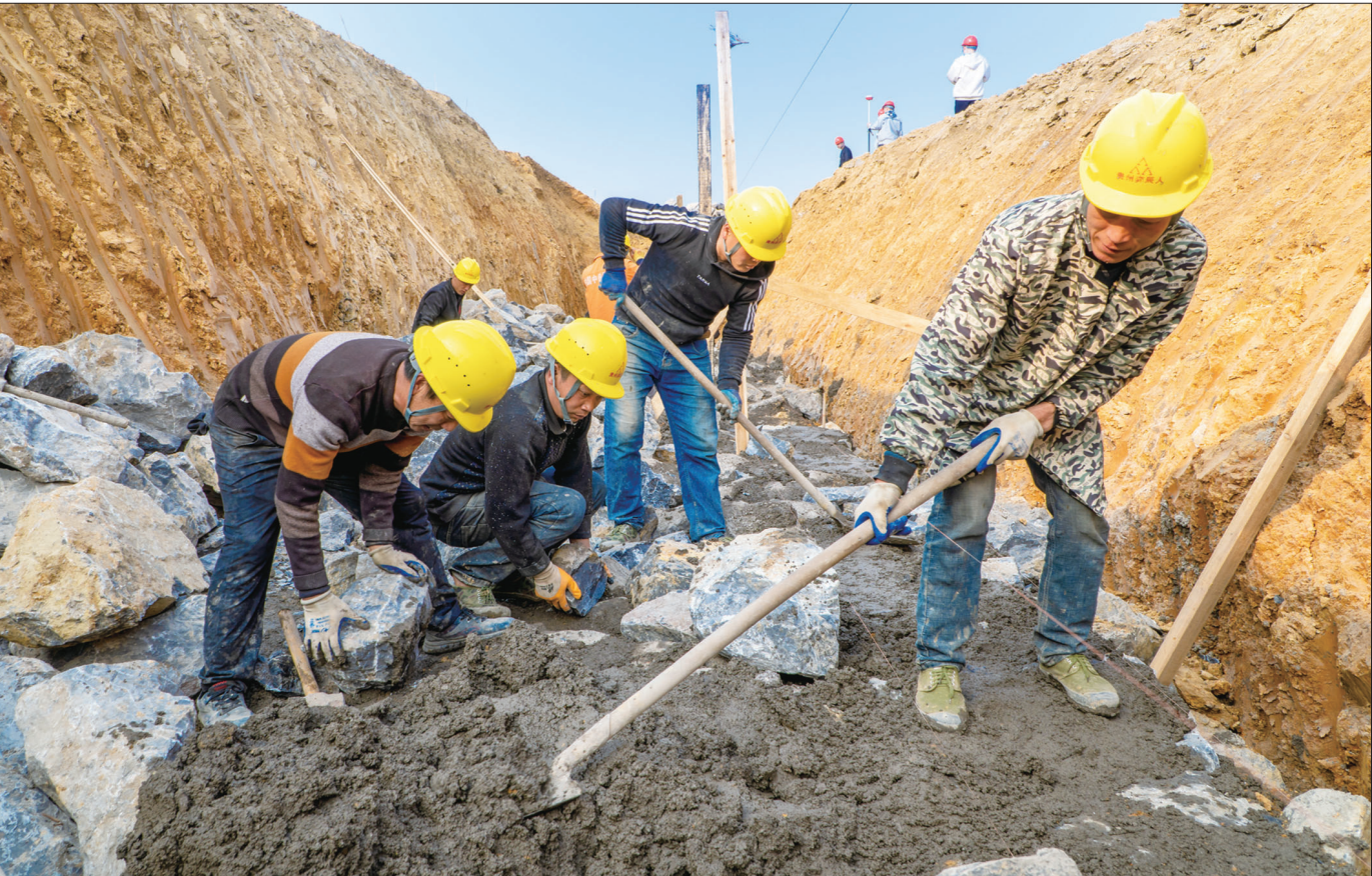
2月26日下午,邵阳县谷洲镇峡口山水库,工人们抓紧修建挡水墙。连日来,工作人员抓住晴好天气,对该水利除险加固工程进行清淤扩容提质建设,施工现场十几辆工程车与挖掘机配合作业运送土石方,呈现一派繁忙景象。邵阳日报记者 唐明业 摄
