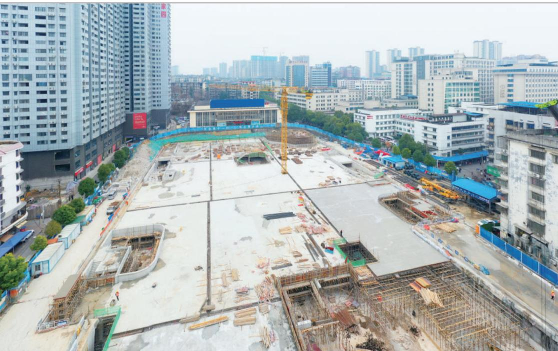
2月22日,市大祥坪体育馆公共停车场项目施工现场,施工人员进行钢筋绑扎及模板加固。该项目计划投资2.18亿元,总建筑面积25733.94平方米,地上有休闲健身广场、跑道、小型足球场等体育运动场所,地下共设机动车停车位715个,其中计划设置充电桩车位218个。预计2月底项目主体结构施工将全面完成,6月底项目整体完工,计划7月试运行。图为即将完成主体结构的大祥坪体育馆公共停车场项目。
