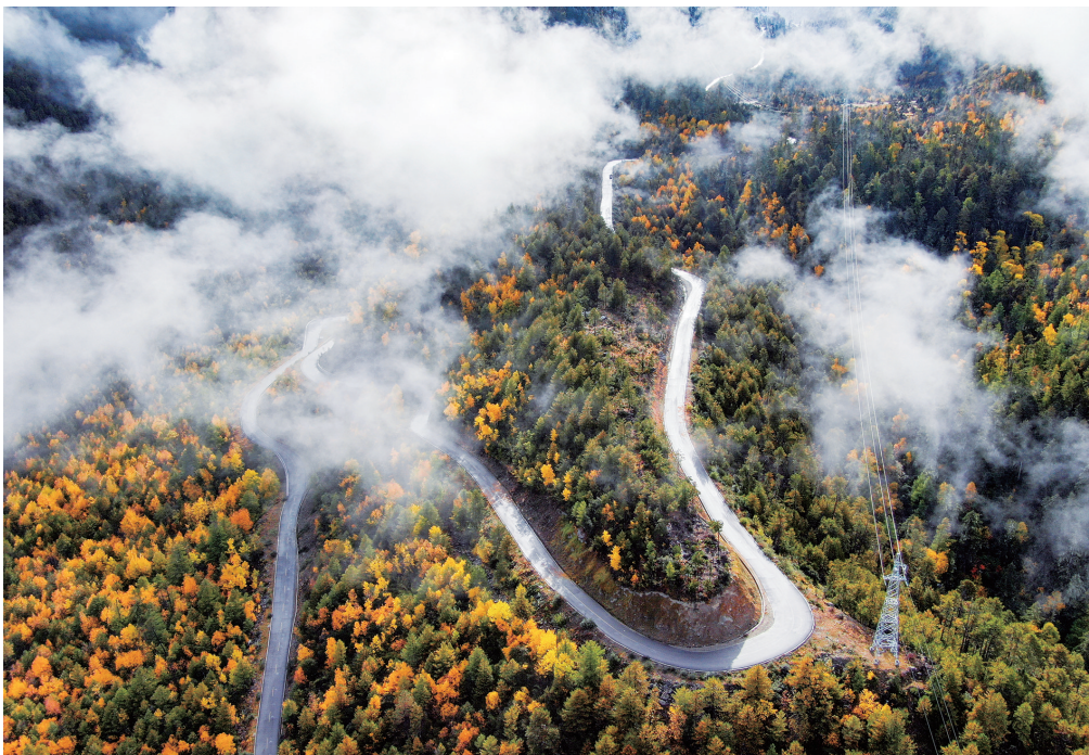
2020年11月5日拍摄的派墨公路米林段一景(无人机照片)。
