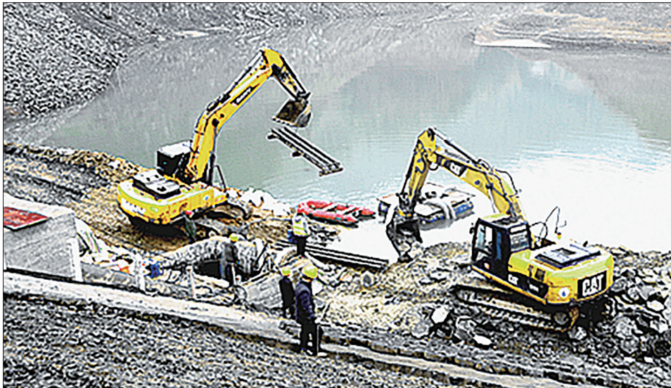
2月19日,在新邵县潭府乡枫树坑水库除险加固项目施工现场,大型机械来回穿梭,工人们正在对防渗墙进行施工作业,并铺设输水管道,保障人民群众生产生活用水。钟鹏 肖祥湛 摄影报道
