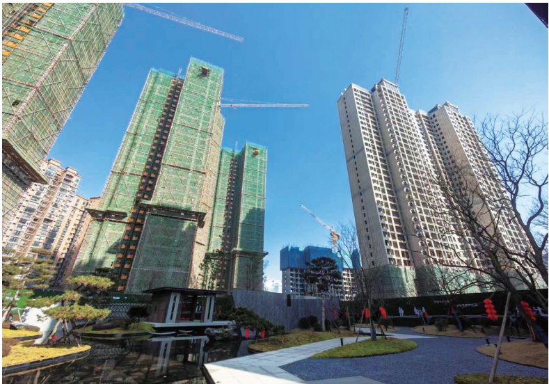
2月1日,大祥区和兴·悦景项目工地。
