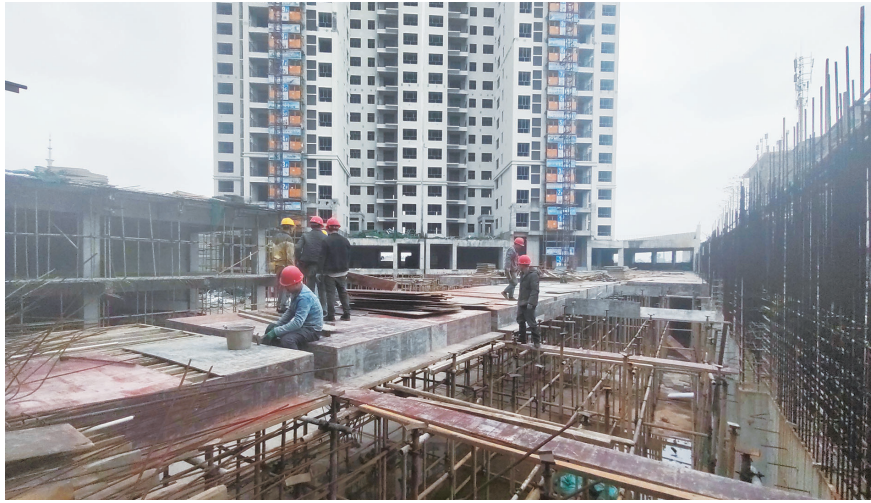
11月23日,北塔区广厦名都项目三期地下车库合围工程正在施工,该项目已全面复工复产。
