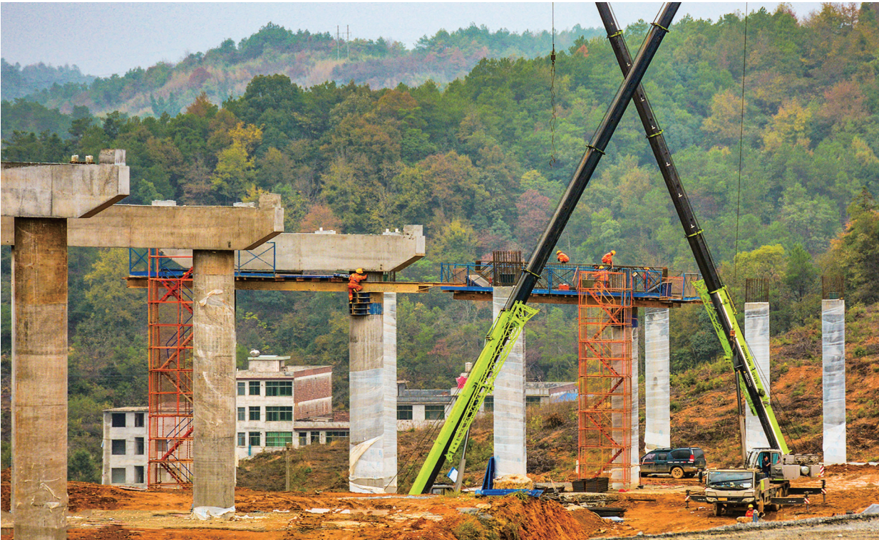
11月21日，新宁县回龙寺镇高枧村高速公路交会枢纽建设工地高架桥墩上，施工人员在做好疫情防控的同时，正在有序施工。 邵阳日报通讯员 郑国华 摄
