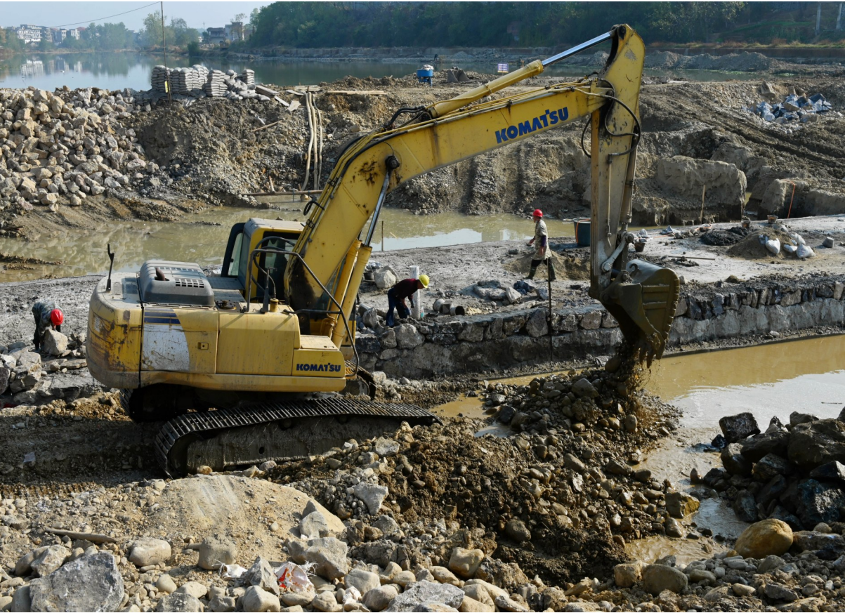
洞口县高沙镇 蓼水河防洪治理工程工地在严格落实好常态化防疫措施的同时,工程建设者正在紧张有序地施工作业。该镇持续加大防洪治理力度,加快完善防洪减灾工程体系建设。 邵阳日报通讯员 滕治中 摄
